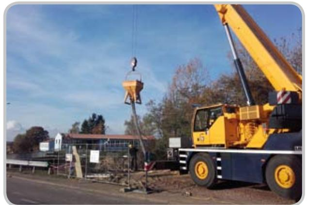
L'entreprise GREBIL a réalisé les fondations, piles et culées nécessaires à la mise en place de la passerelle.
