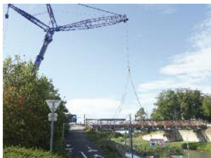
Le nouvel ouvrage, en cours de construction, s'appuiera sur les culées existantes qui ont été renforcées sur leurs parties supérieures. Le tablier sera de composition mixte, en acier et en béton, de même type que l'ouvrage installé sur le pont de la Sarre en 2019.
