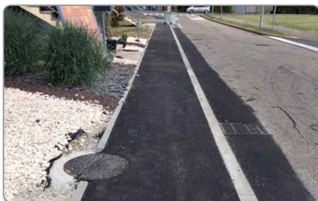
Rue du Général Marulaz - Après
