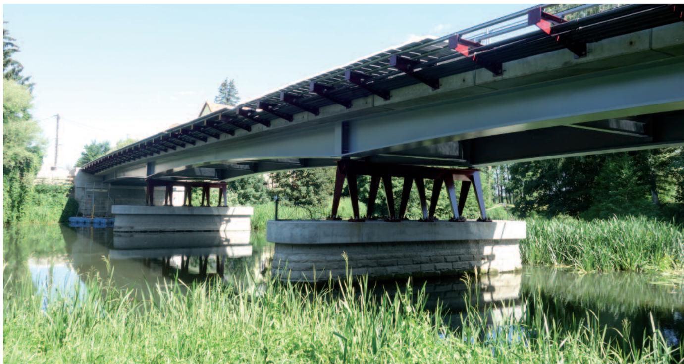
Après la mise en place d'une passerelle piétonne provisoire permettant le franchissement de la Sarre par les piétons pendant les travaux, l'ancien ouvrage a été démolí à l'été 2018. Cet ouvrage, datant des années d'après-guerre, présentait d'importants dégâts structurels.
